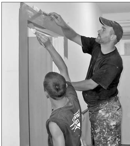
Az óvoda 2010-es felújítása
